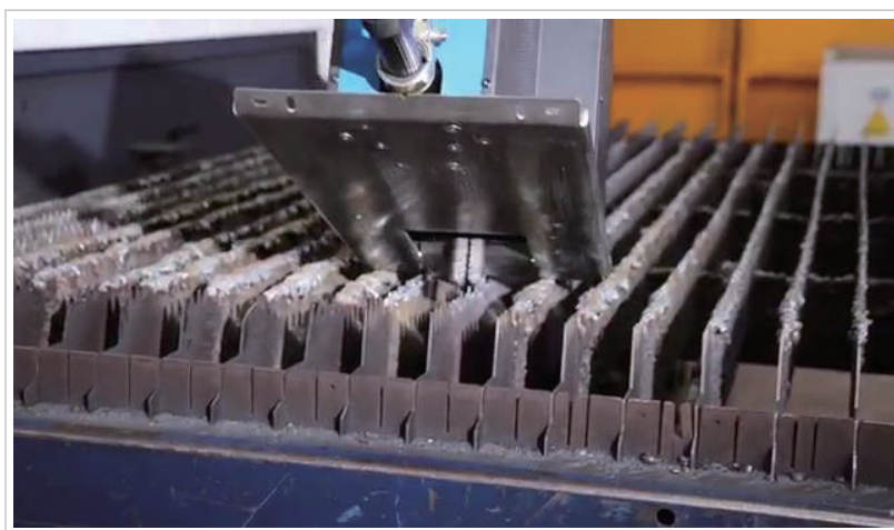
Rys. 8. Czyszczenie listwy: maszyna prowadzona wzdłuż listwy, narzędzie kruszy żużel z obu stron.
